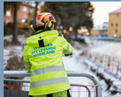
Flyttade lång fjärrvärmeledning.
